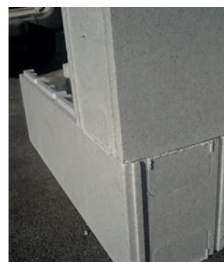
Détail d'angle avec bouchons assemblés
