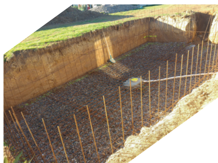
Treillis avec attentes verticales
